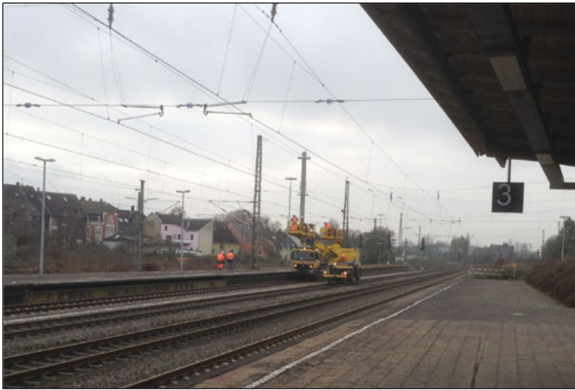
Bildtext: Streckenbauarbeiten am Bahnhof Herne. (Noch bis Mitte Februar ist an den Wochenenden der Zugverkehr zwischen Dortmund und Gelsenkirchen sowie zwischen Bochum und Wanne-Eickel nur eingeschränkt möglich. Es fährt Schienenersatzverkehr.)
